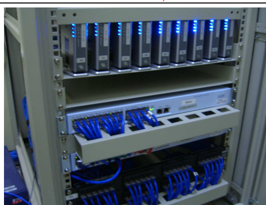
FOTO 2: modem Embratel, Servidor iVoIP e ATA's Cisco.
